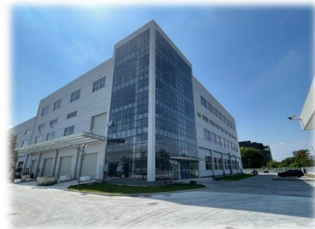
▲杭州泰谷諾石英有限公司 第三工場
